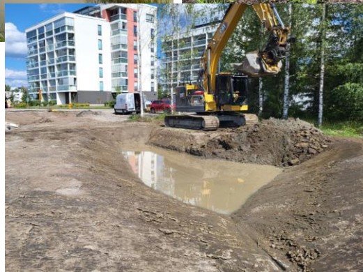
Horsmatien vanha tilanne ja alueelle rakennettu vanematkanpuiston allas sekä Sävelpuiston hulevesien viivytys altaan rakentamista
